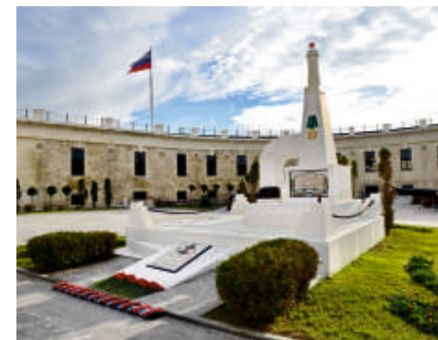
Внутри Константиновской батареи. Фото: Юрий Югансон
